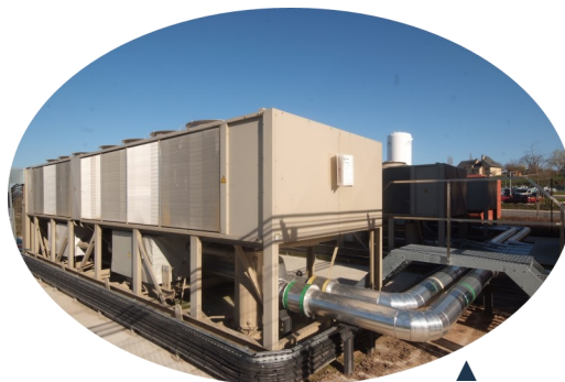
PAC air/eau et groupe d'eau glacée à condensation à air ▲
