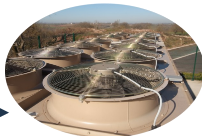
PAC air/eau et groupe d'eau glacée à condensation à air ▲
